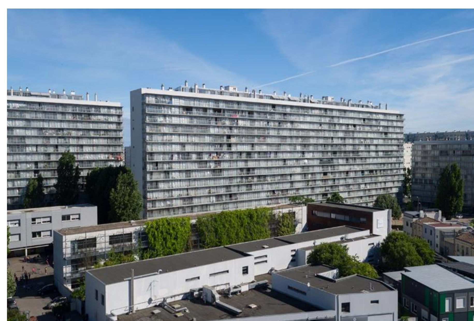
Figura 02 - Edifícios após a intervenção
